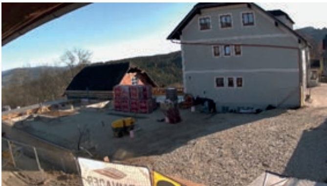
KW46: Unterbau, Bodenplatte für Großlager und Aufstockung auf die Räumlichkeiten der Sportunion Fischbach, Raum für FW-Jugend, Seminare und Aufenthalt aufmauern
