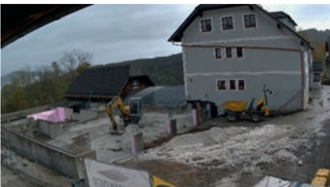
KW44: Unterbau, Abdichtungsarbeiten, Hauskanäle, Fertigteilmfundamente, Dach der Räumlichkeiten der Sportunion Fischbach abtragen
