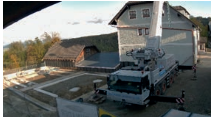
KW43: Unterbau, Abdichtungsarbeiten, Hauskanäle
