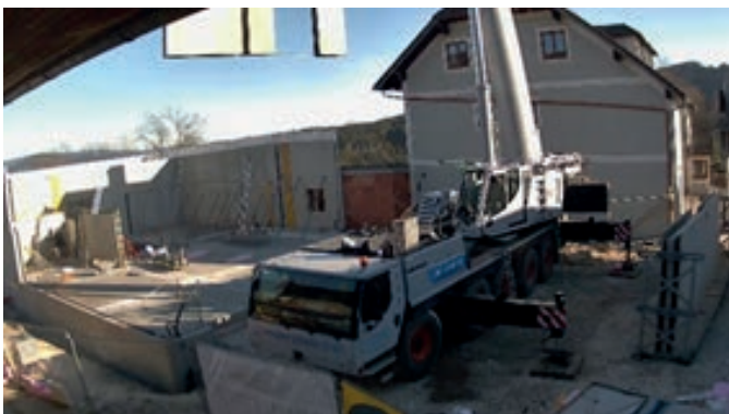
KW48: Hallenbodenplatte, aufgehende Fertigteilhohlwände
