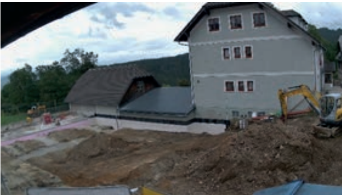
KW40: Unterbau, Abdichtungsarbeiten zum Bestand, Drainagen, Anschlussarbeiten an Bestand
