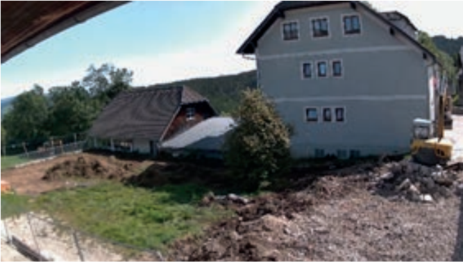
KW38: Baufeldfreimachung, Baustelleneinrichtung
