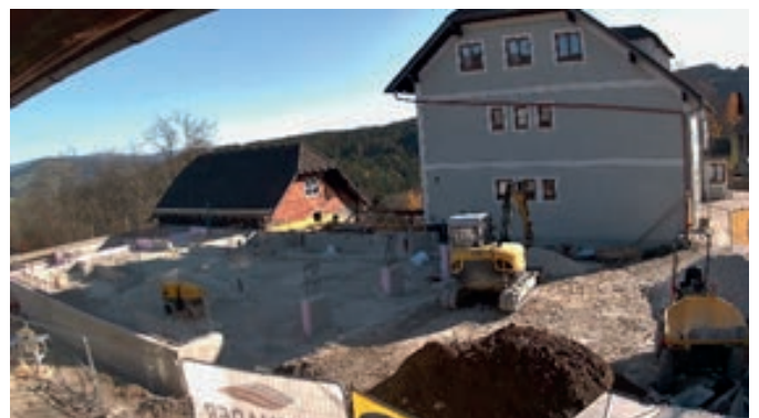
KW45: Unterbau, Abdichtungsarbeiten, Hauskanäle, Fertigteilmfundamente, Dach der Räumlichkeiten der Sportunion Fischbach abtragen und Leitungen umlegen
