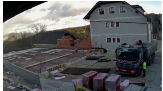
KW47: Hallenbodenplatte, Fußbodenheizung, Raum für Feuerwehrjugend, Seminare und Aufenthalt aufmauern
