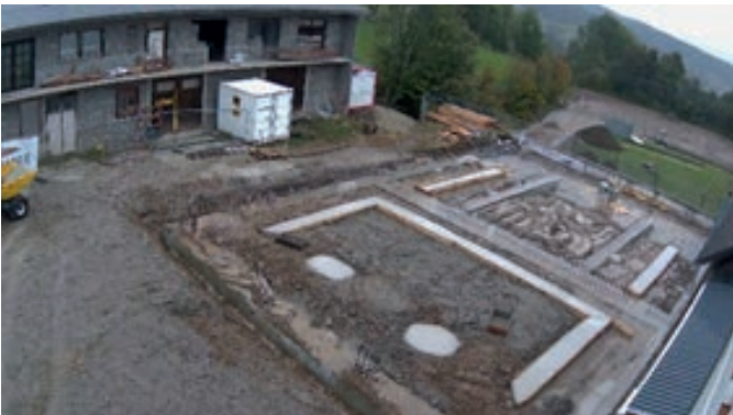
KW42: Unterbau, Abdichtungsarbeiten, Drainagen, Fundamente
