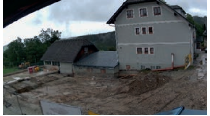
KW39: Baugruben- und Fundamentaushub, Unterbau, Anschlussarbeiten an Gemeindewerkstatt
