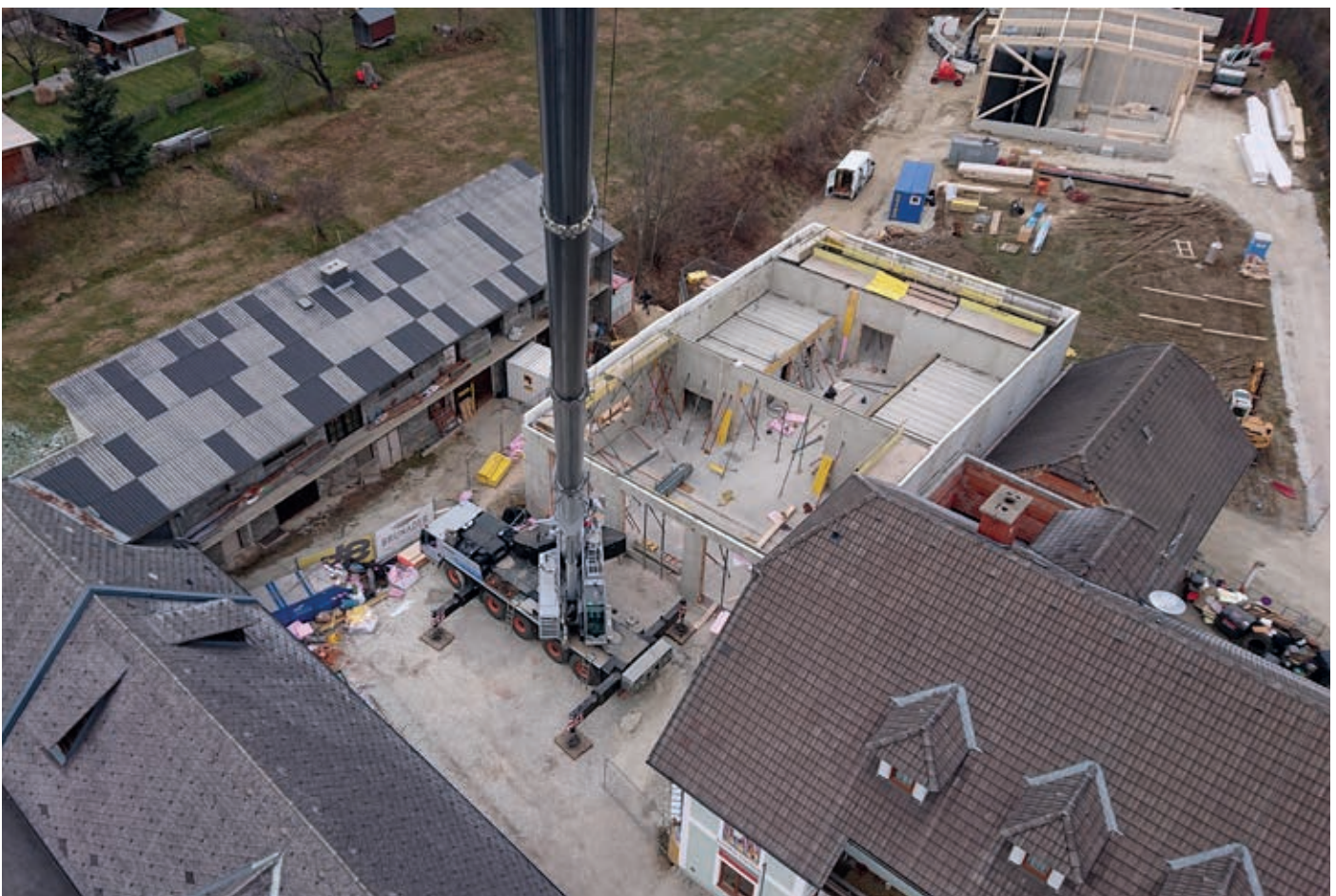
KW48: Hallenbodenplatte, aufgehende Fertigteilhohlwände
